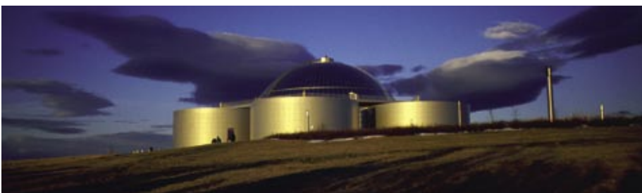
Heißwassertanks mit Aussichtsplattform und Restaurant
